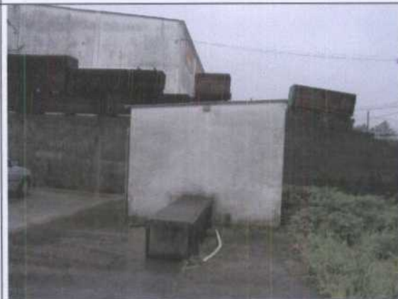
Vista exterior de la caseta del sondeo
