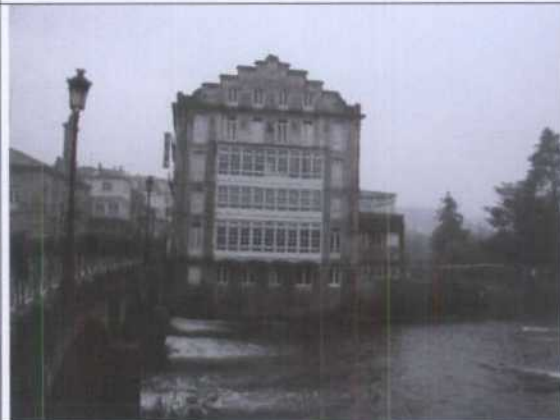
Edificio balneario Acuña, junto al río Umia
